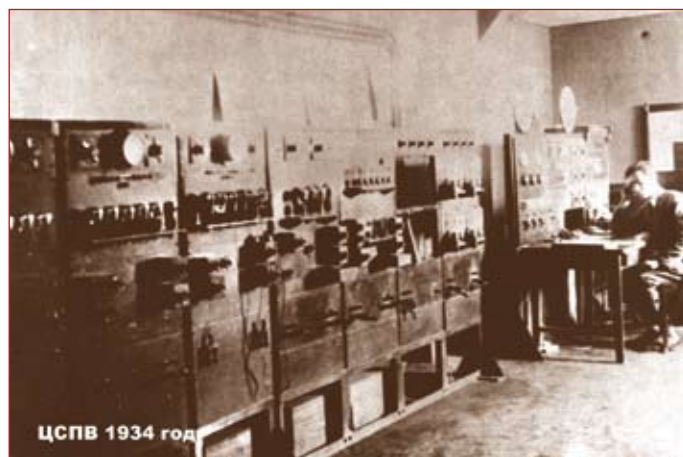
Аппаратная Центральной усилительной станции МГРС
