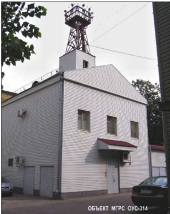
Здание опорно-усилительной станции, обслуживающей 100—120 тысяч радиотрансляционных точек
